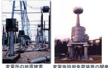
変電所の地震被害 变電施設用免震装置の開発
